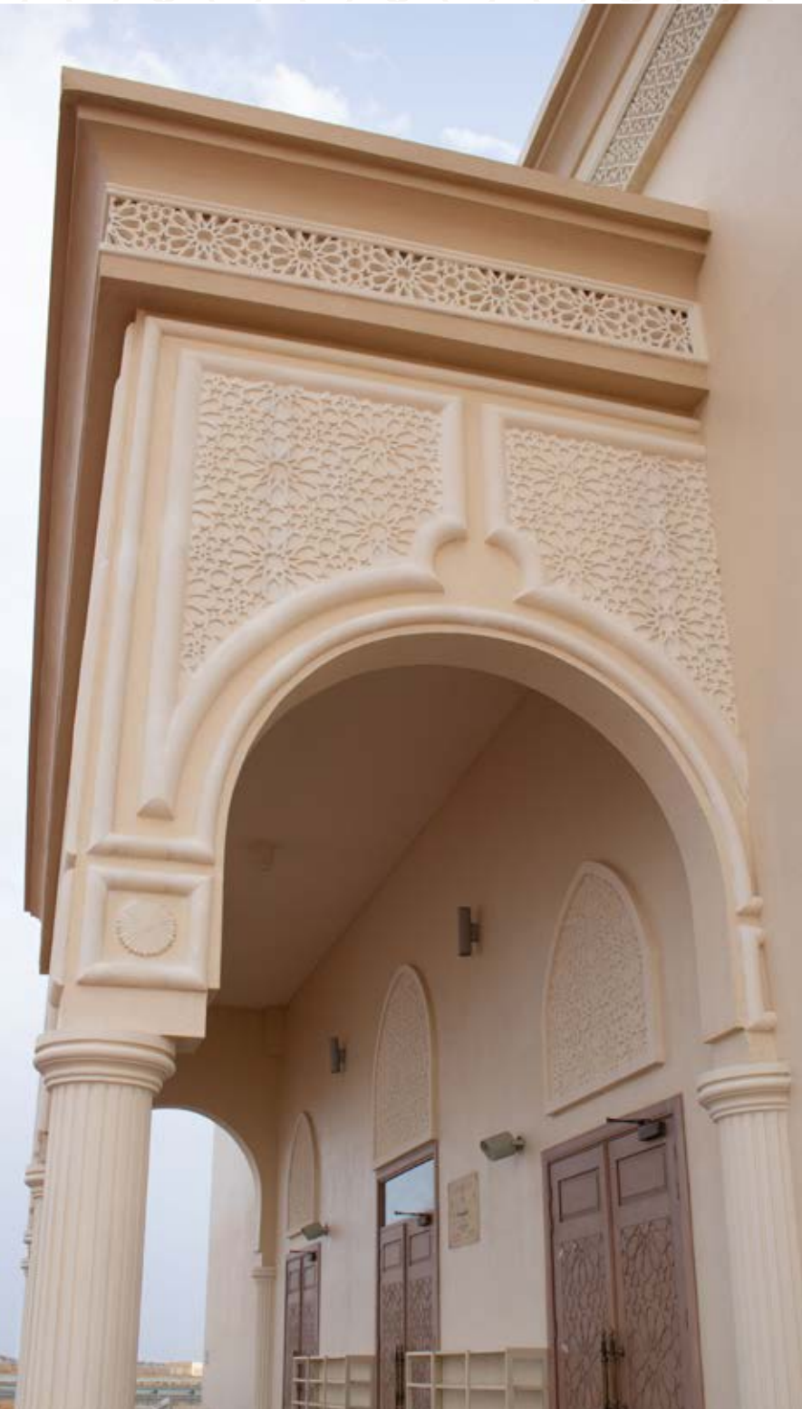
لقطة جانبية لمدخل مسجد سهيلة
