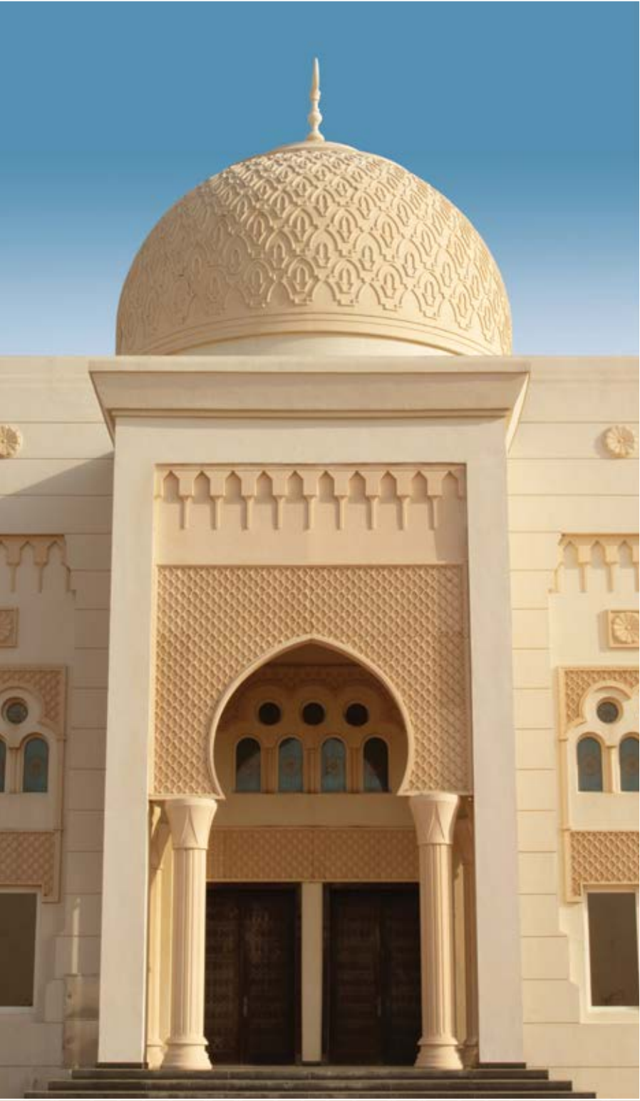
لقطة أمامية لمدخل مسجد مليحة
